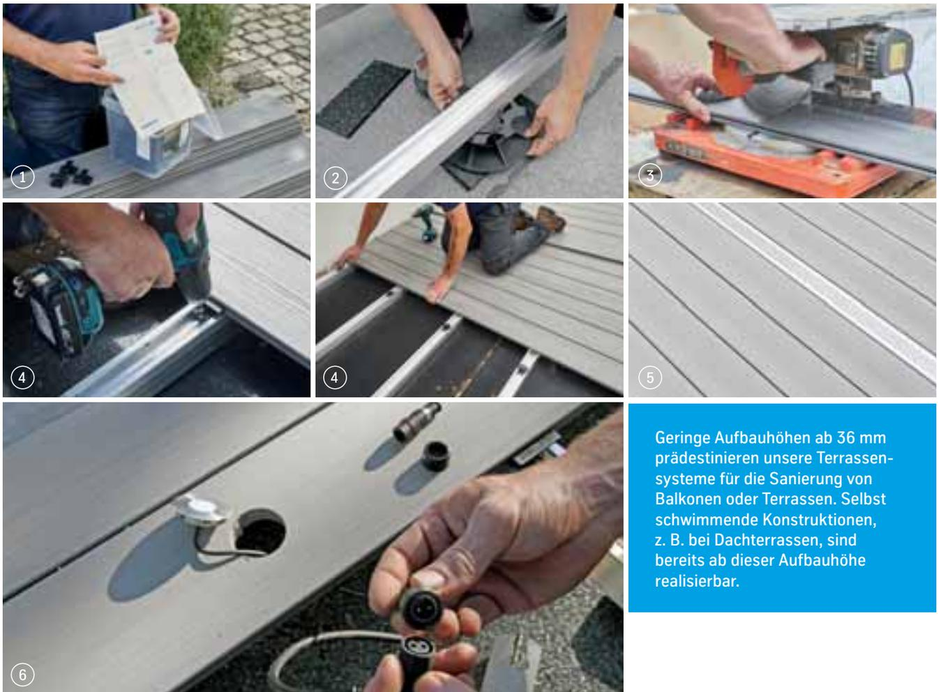
Geringe Aufbauhöhen ab 36 mm prädestinieren unsere Terrassensysteme für die Sanierung von Balkonen oder Terrassen. Selbst schwimmende Konstruktionen, z. B. bei Dachterrassen, sind bereits ab dieser Aufbauhöhe realisierbar.
