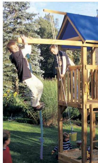
Die Strickleiter wird mit zwei Schaukelhaken, das Knotenseil mit einem Schaukelhaken befestigt. Die Haltegriffe finden Sie auf Seite 31.
