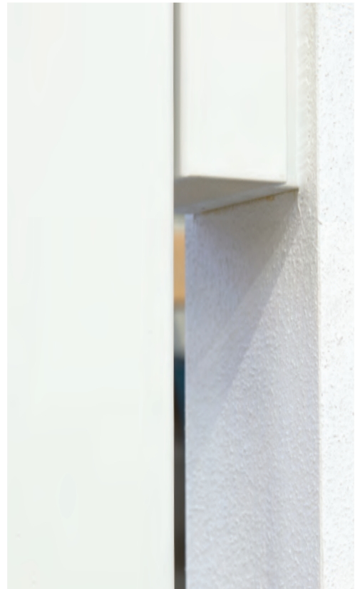
Detail: Blockzarge auf verputzter Laibung
